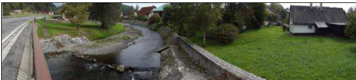
Obrázek 59: Silniční most v Hrabačově
