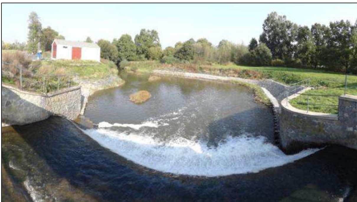
Obrázek 37: Vodní elektrárna nad Bojmany
