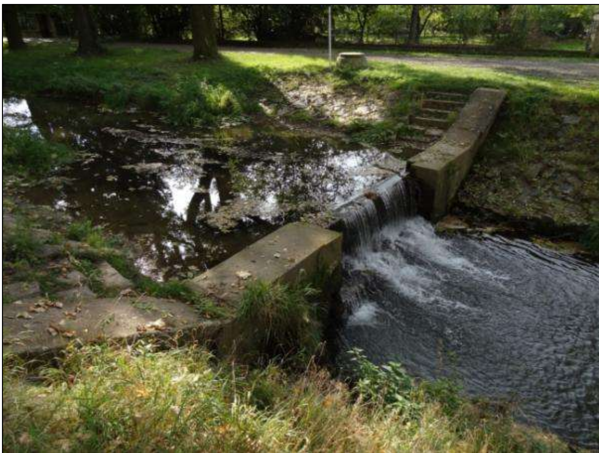
Obrázek 29: Stupeň ve dně nad pivovarem
