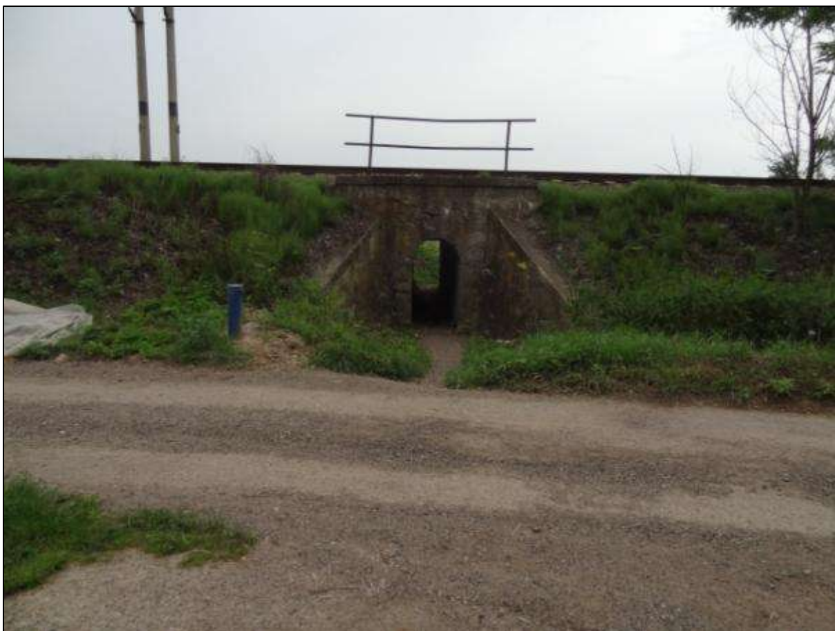
Obrázek 94: Průchod pod železničním náspem
