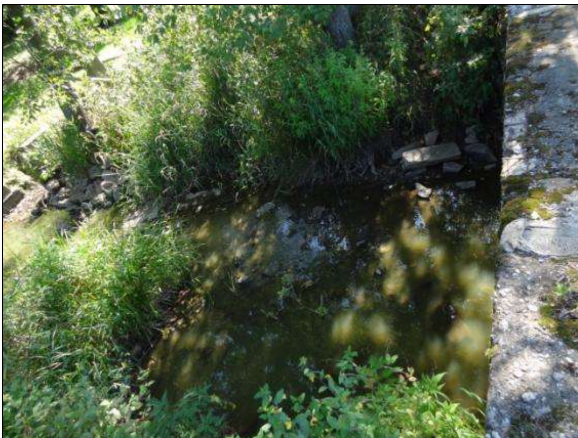
Obrázek 132: Můstek přes Střelu
