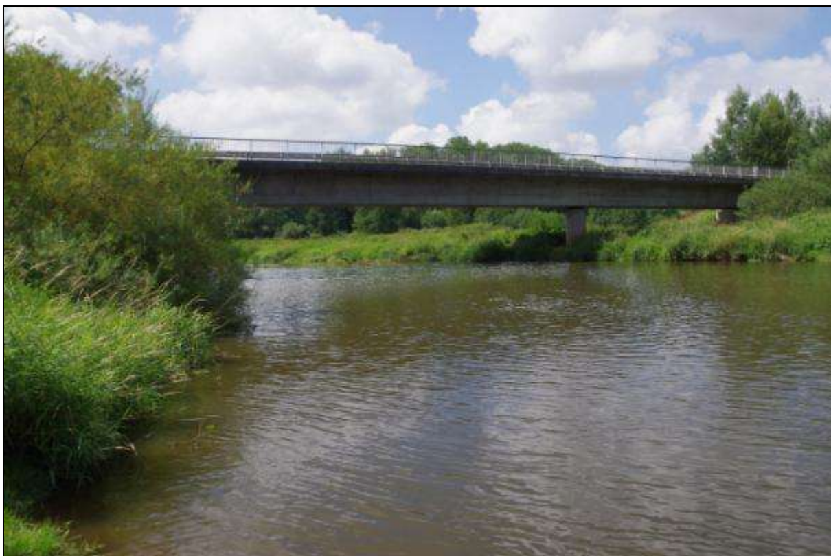
Obrázek 48: Silniční most přes Lužnici
