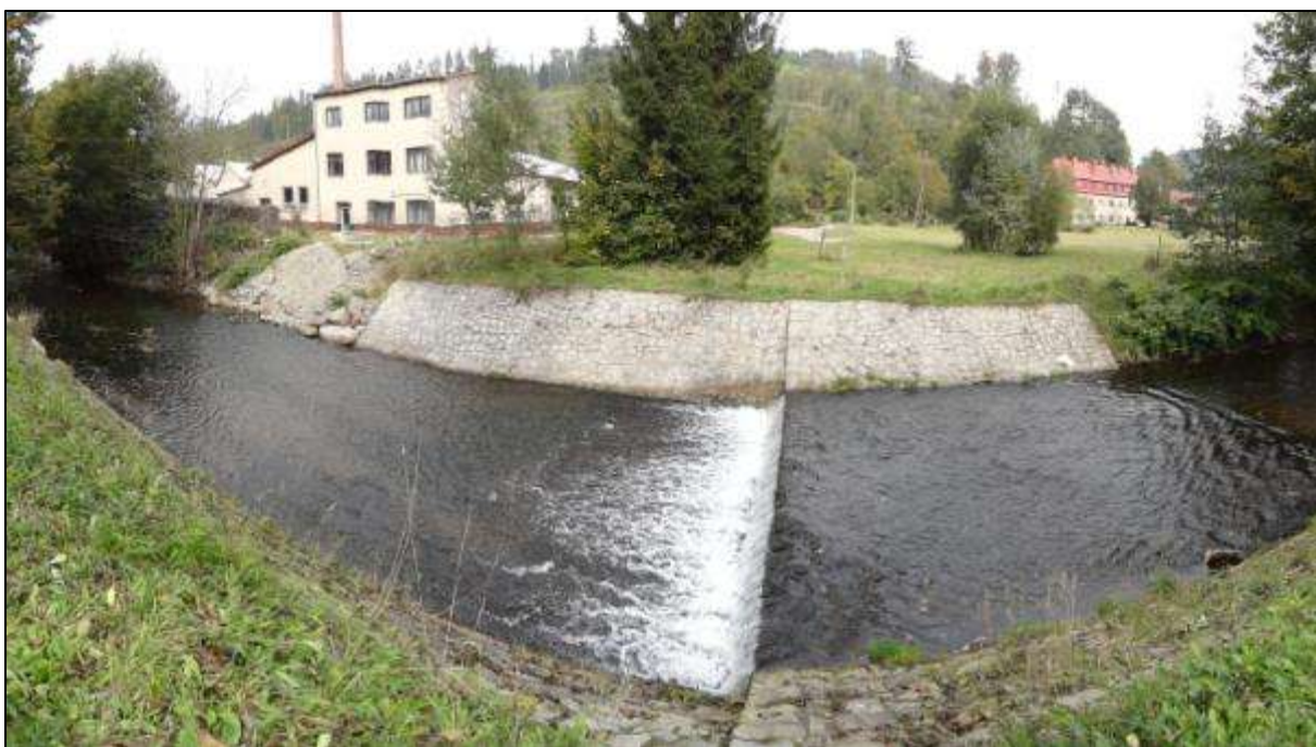
Obrázek 63: Stupeň u úpravny vody
