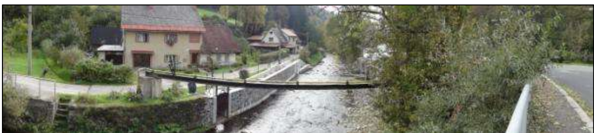
Obrázek 65: Překlenutí Jizerky potrubím
