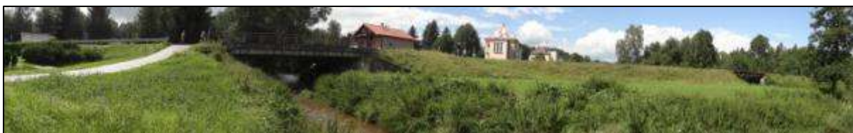
Obrázek 111: Silniční most v Bělé
