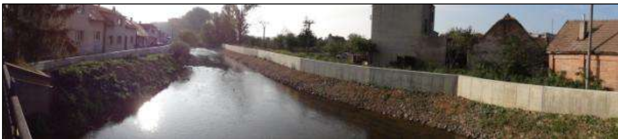
Obrázek 43: Protipovodňová ochrana ve Vrdech
