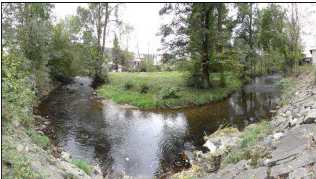
Obrázek 66: Koryto upravené kamennou rovnaninou
