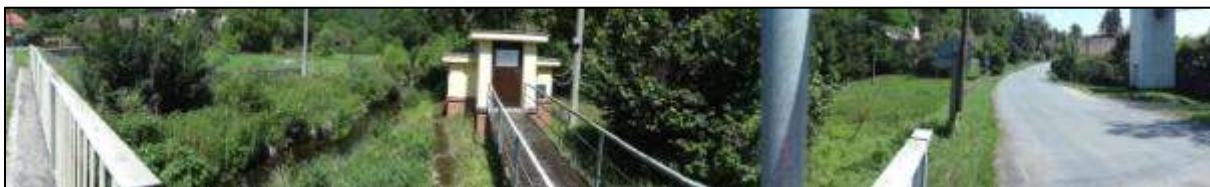
Obrázek 100: Čerpací stanice podzemních vod
