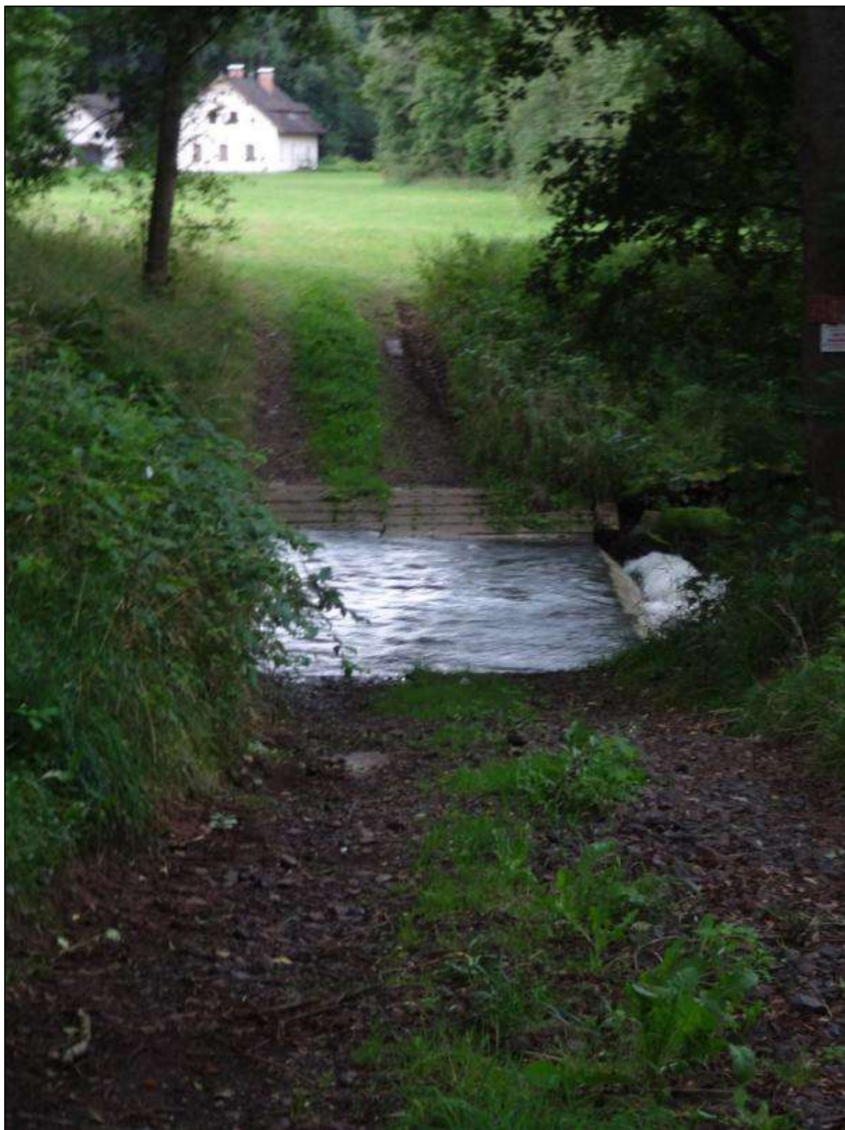
Obrázek 115: Brod se stupněm ve dně
