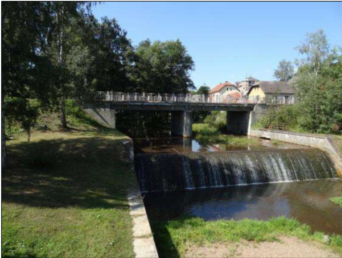
Obrázek 121: Silniční most přes Manětínský potok
