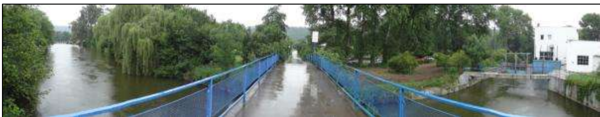
Obrázek 91: Vodní elektrárna U Zadní Třebaně
