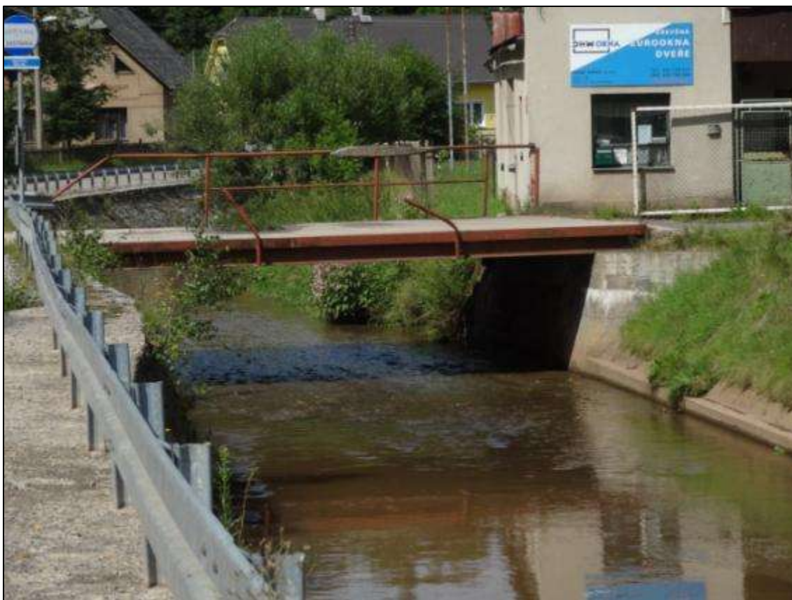
Obrázek 113: Opevnění koryta
