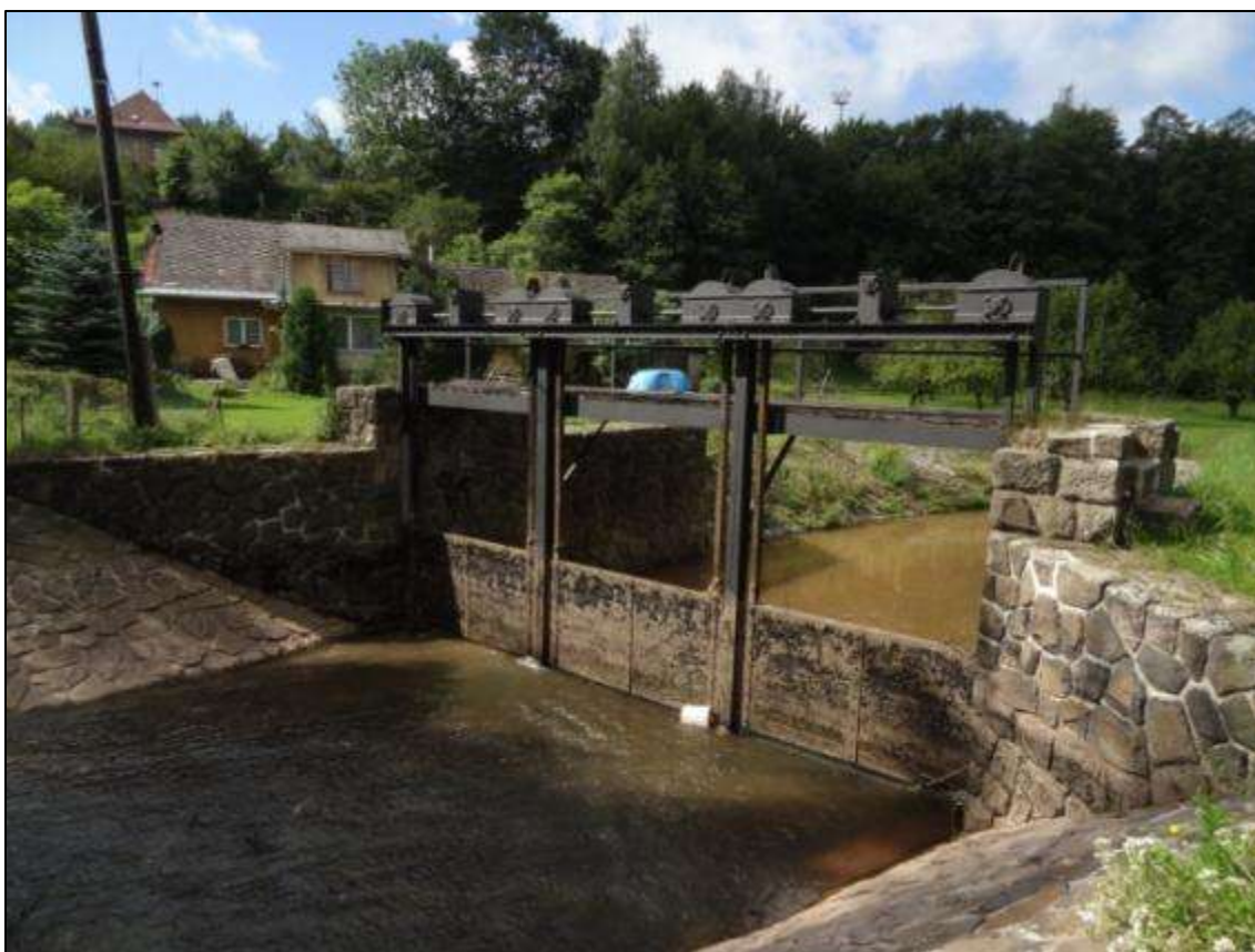
Obrázek 114: Stavidlo na Olešce
