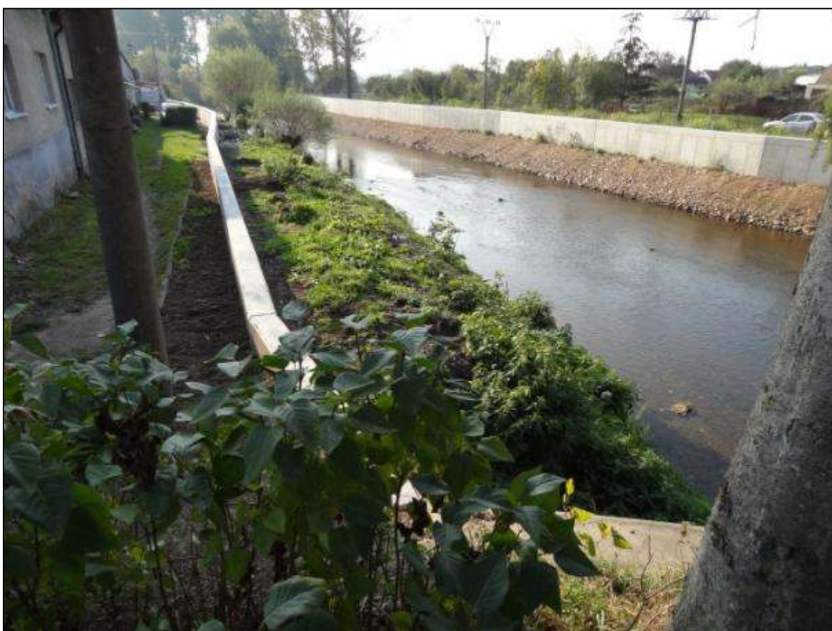
Obrázek 40: Protipovodňové zdi na Doubravě
