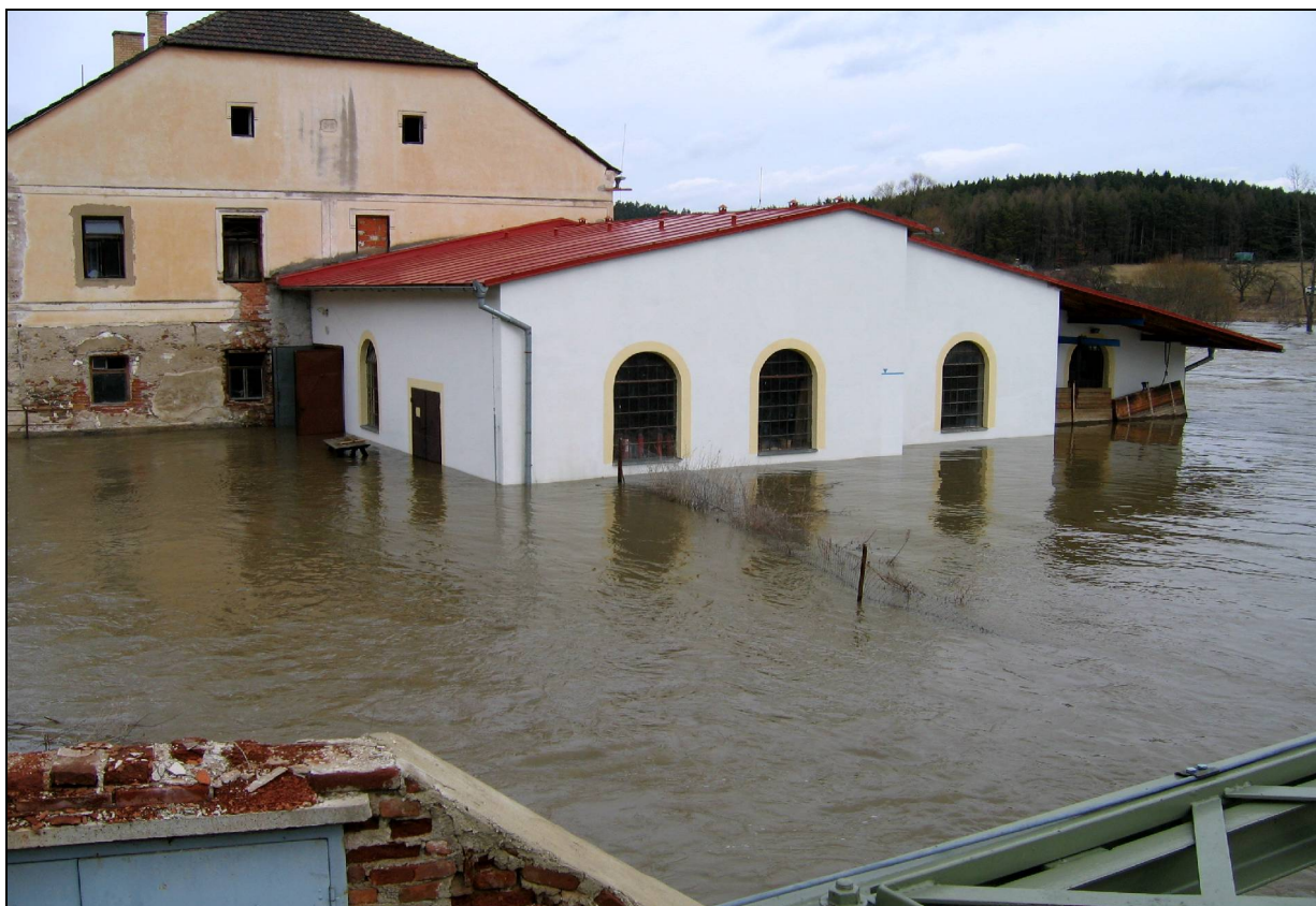
Obr.č. 6 – Lužnice - Dobronice - malá vodní elektrárna
