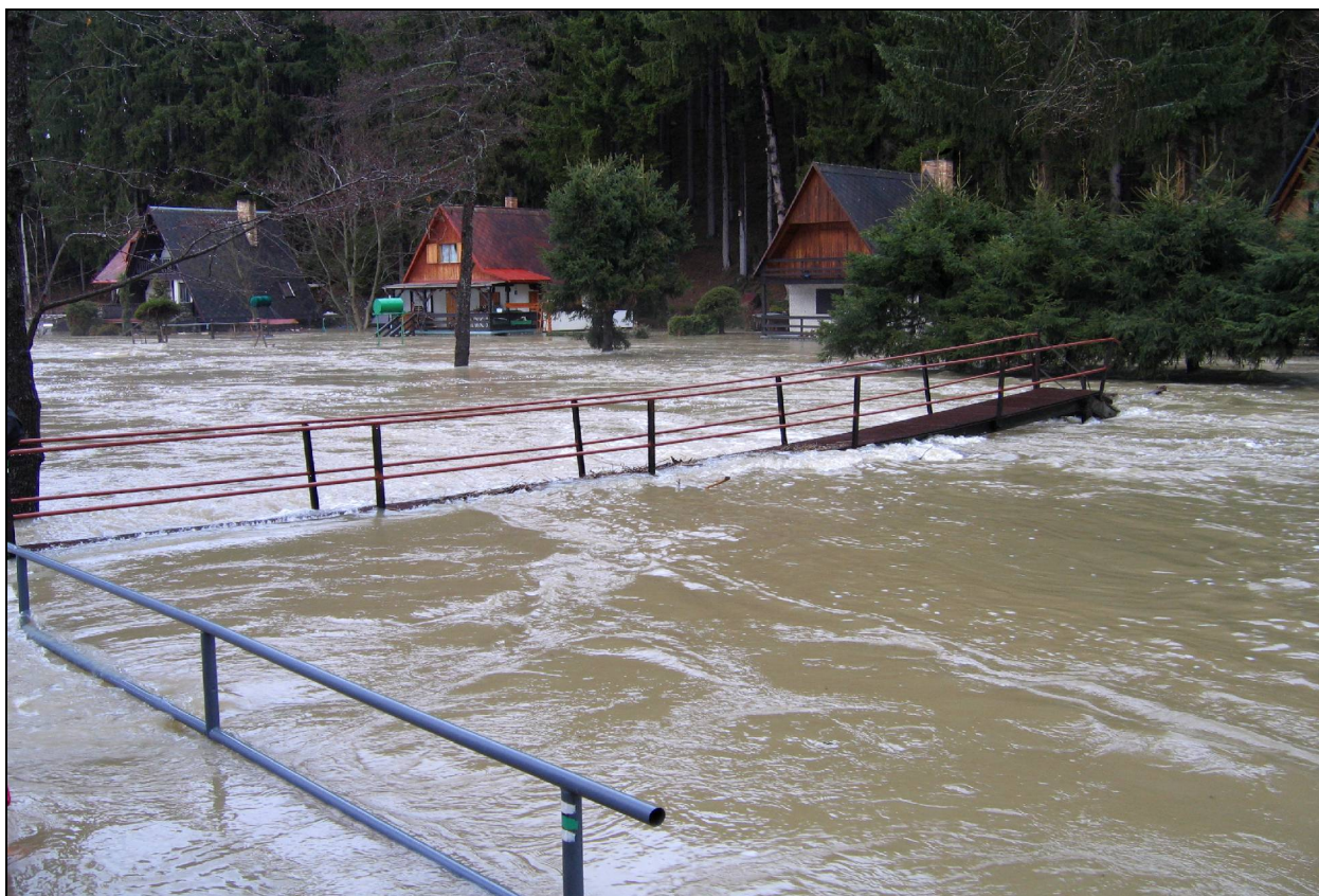
Obr.č. 9 – Stropnice – lávka
