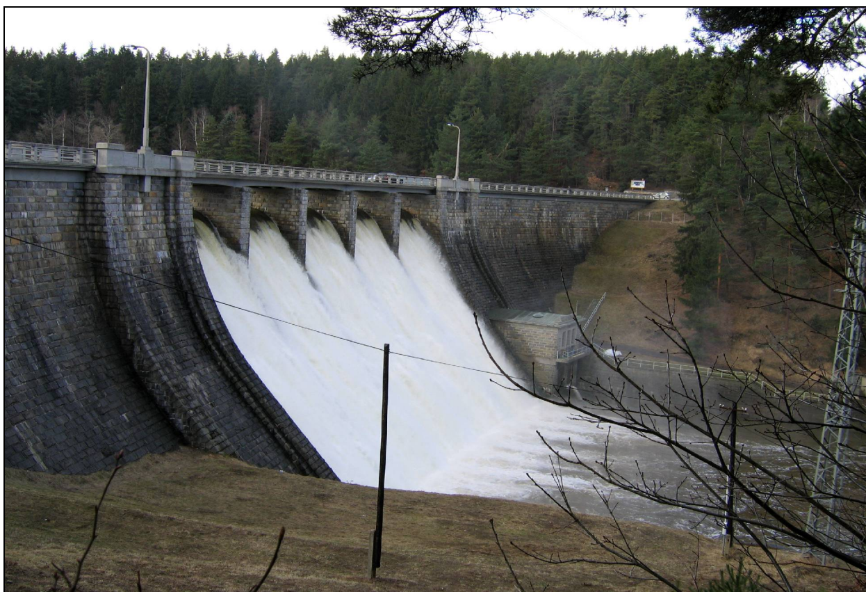
Obr.č. 10 – Blanice - VD Husinec – Přepad vody přes přelivy
