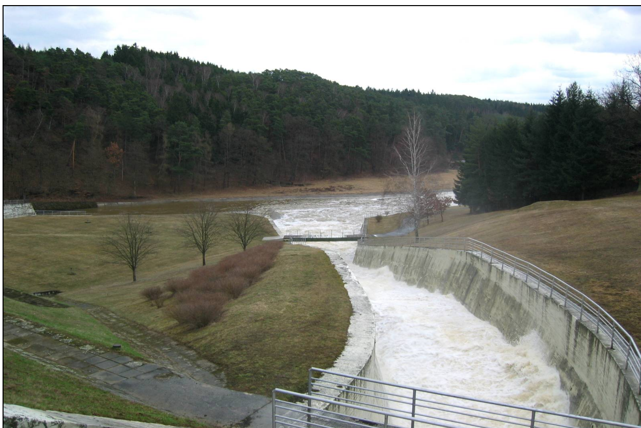
Obr.č. 20 – Mže - VD Hracholusky- pohled pod hráz na vývar a skluz od bočního přelivu
